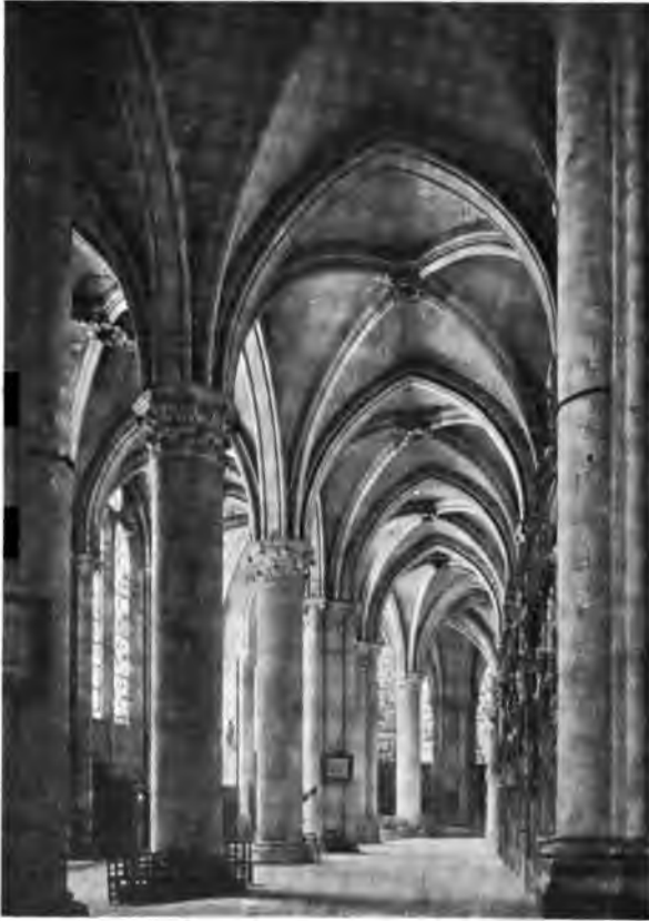
Fig. 153. — Voûtes sur croisée d'ogives du collatéral nord à la cathédrale de Chartres. Coïncidence parfaite entre la structure et la décoration.
